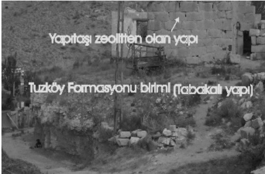
Şekil 8. Zemini Tuzköy formasyonu biriminden oluşan ve yapı taşı zeolit biriminden olan yapı.
